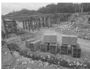
沙河橋施工照 拍攝者：張惟哲 博士
